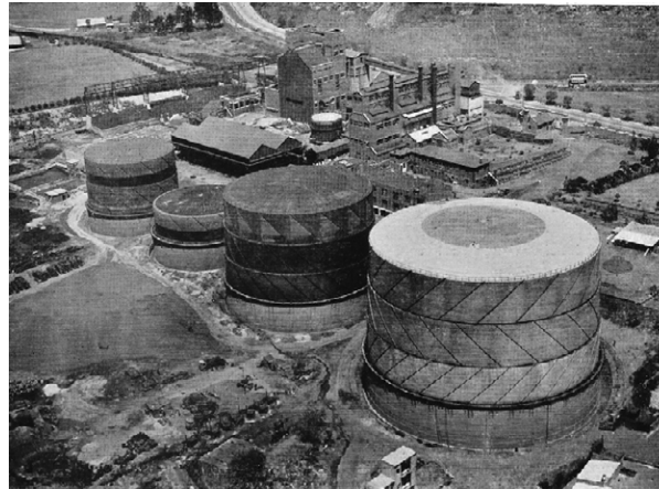
Fig 25 1953 Aerial view on gas works (Archives of Läuferst le Roux, 2017)
