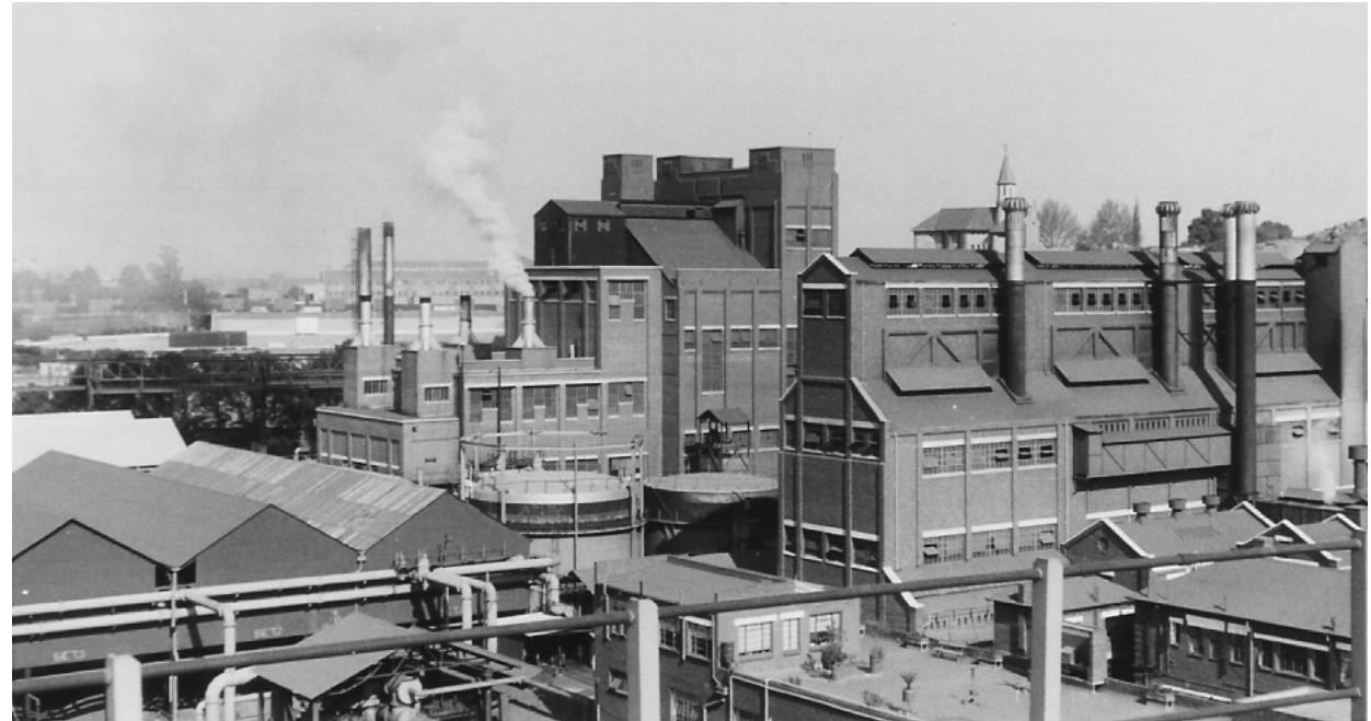
Fig 41 1960 General view (Archives of Läufer's le Roux, 2017)
