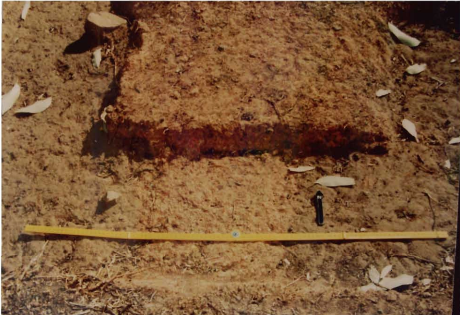
Figuur 8.11 Detail van die gekompakteerde kleilaag onder die vloer van die bad- en strykkamer.
