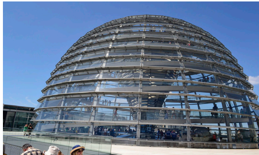
Figure 4.16: Dome structure (van der Klashorst, 2013)
