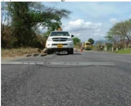
(D) Rutting on Mikumi-Iyovi road section
