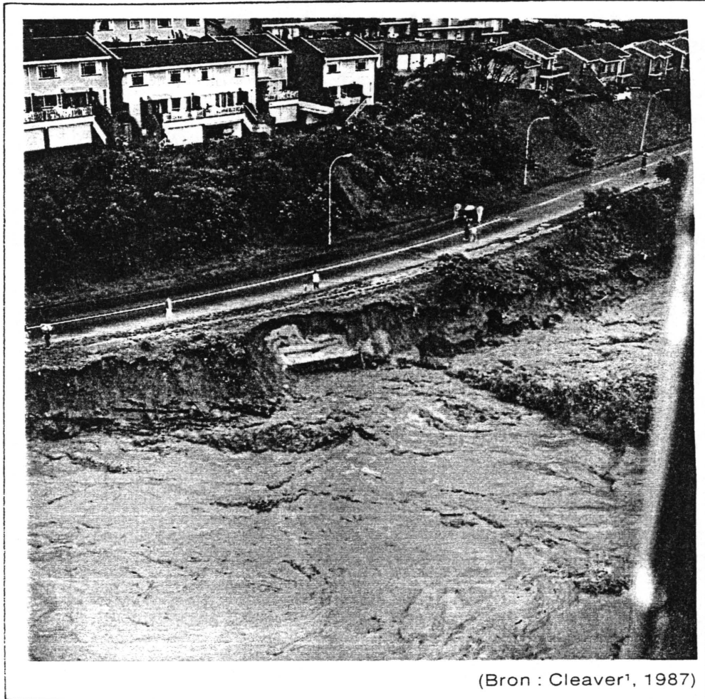
FIG. 3.16: VLOEDSKADE TYDENS DIE 1987-VLOEDE LANGS DIE NOORDELIKE OEWER VAN DIE MGENI-ESTUARIUM TOON VERSAKING VAN DIE OEWER EN SKADE AAN DIE HOOFRIOOLPYP
