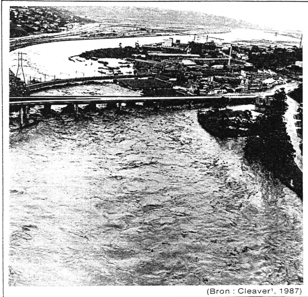
FIG. 3.13: VLOEDWATER VLOEI DEUR AL DIE BOË VAN DIE CONNAUGHTBRUG EN DIE NUWE SPOORWEGBRUG TYDENS DIE SEPTEMBER 1987-VLOEDE
