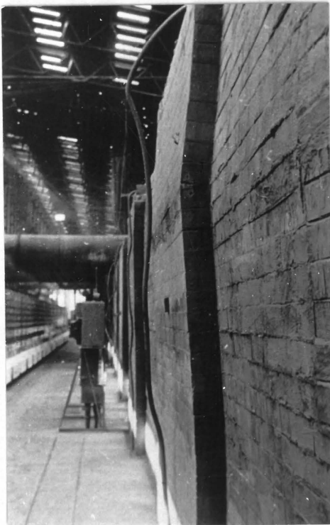
foto 31 ◁ SWIGTING VAN DIE MUUR VAN 'N VOORVERHITTINGSONE
