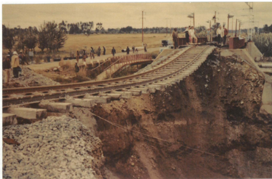
foto 36 SINKGAT ONDER DIE SKAKELSPoor NA VENTERSPOSTMYN OP 4 APRIL 1963
