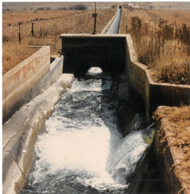
foto 2 KANALISERING VAN MYNwater VANAF WES-DRIEFONTEINMYN
