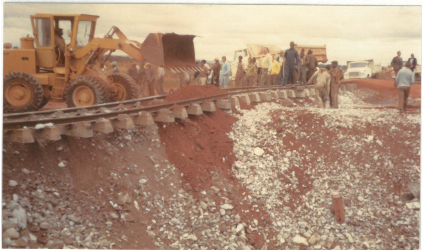
foto 40 OP 10 APRIL 1975 WAS DIE SINGKAT GEVUL EN HET TREINE WEER GELOOP.
