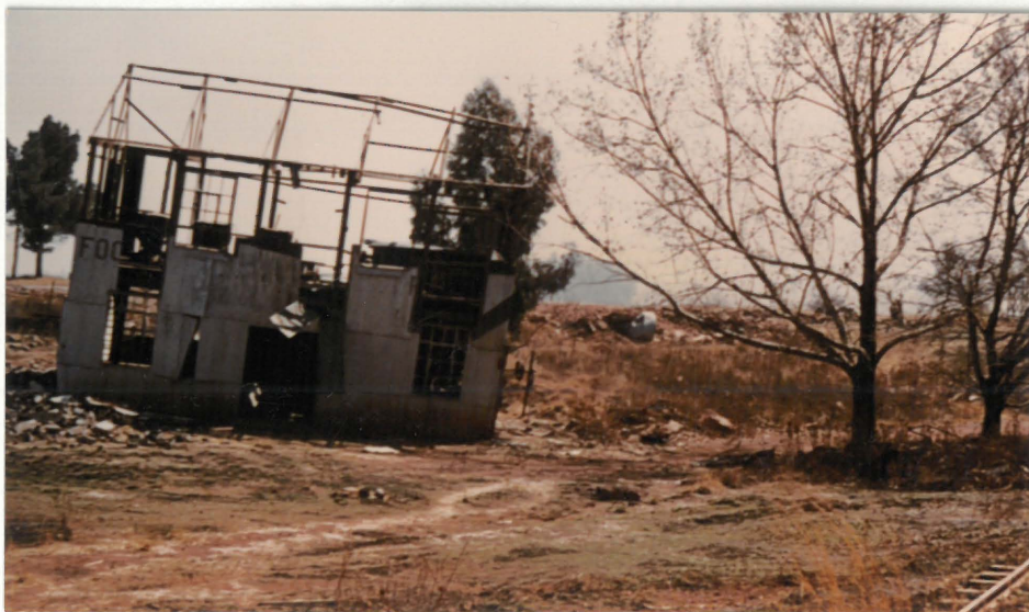
foto 46 KANTELING VAN BANK-ROLLERMEULE. DIE HORIZONLYN GEE 'N AANDUIDING VAN SOWAT 3M SAKKING.
