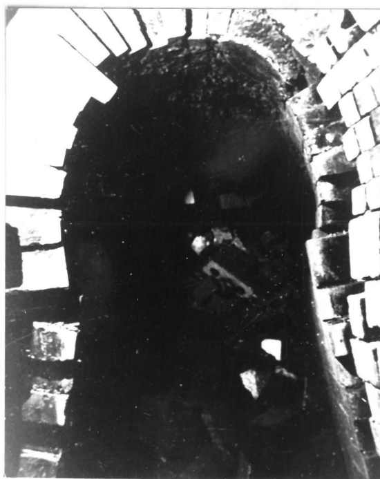
foto 33 TIPERENDE VERWRINGING VAN DIE VOERINGSTONE IN DIE UITGEDIENDE SUIDELIKE GASTOEVOERTONNEL. DRUKSPANNING IN DIE DAK HET LINIËRE BOGGELS IN DIE BAKOONDSONES VAN AL SES TONNELOONDE VEROORSAAK.
