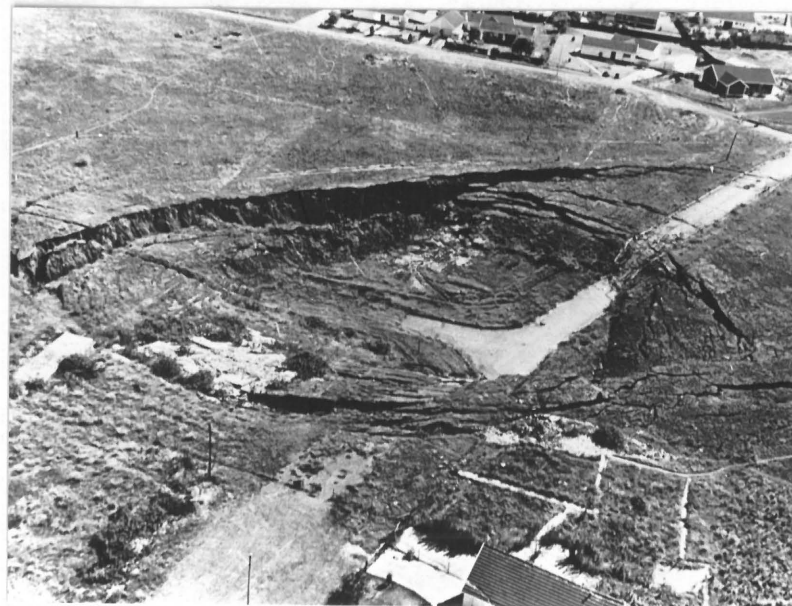
foto 18 SCHUTTE SE VERSAKKING IN CARLETONVILLE. ONGEVEER 8m DIEP. KOMPAKSIEVERSAKKING HET SOWAT VIER JAAR GEDUUR.
