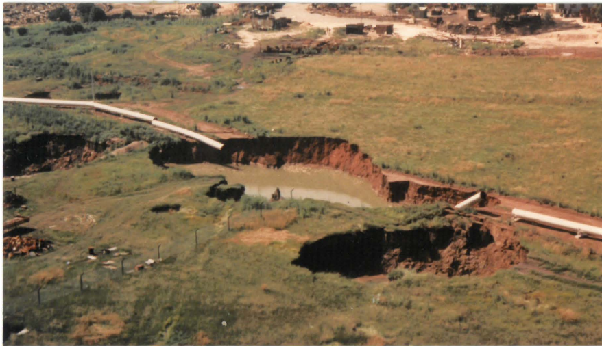
foto 3 SAAMTROSSING VAN SINKGATE LANGS DIE WONDERFONTEINSPRUIT NA 'N WOLKBREUK IN JANUARIE 1978. DIE 1000MM PYPLYN OP DIE FOTO VERVOER STORMWATER OOR 'N AFSTAND VAN 28KM VANAF VENTERSPOSTMYN TOT BY DIE KANAALSTELSEL VAN WES-DRIEFONTEINMYN.
