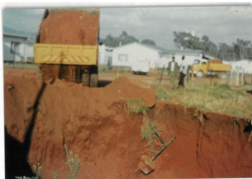
foto 14 INVULLING VAN 'N SINKGAT WAT ONTSTAAN HET AS GEVOLG VAN ONTWATERING DEUR MOBILISERING VAN DIE VULSEL VAN 'N OERSINKGAT.
