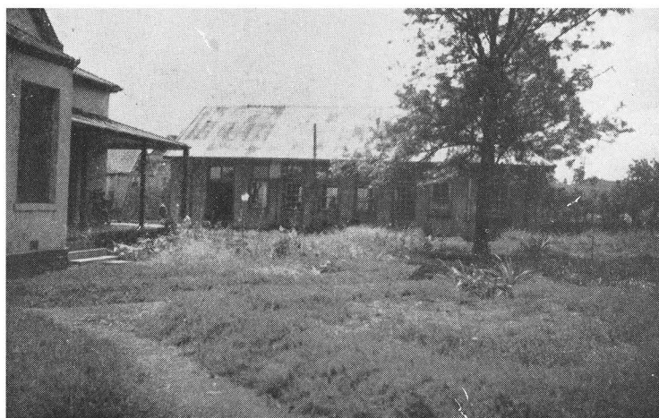
Die „New Lecture Hall ” met „Cottage ” links. Agter is hulle besig om die „Bungalow ” te sloop.
