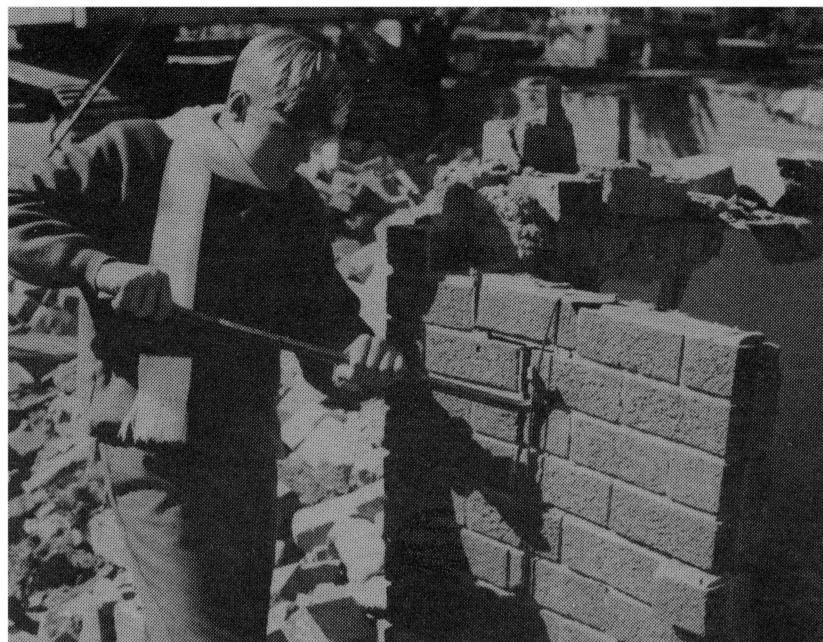
Igmon Becker help koshuis afbreek ... Die bouwerk aan die nuwe koshuis en opgradering van die personeelakkomodasie beloop R2,3 miljoen rand. Vanweë die groot toename in die leerlinggetalle, sal daar nou vir nog 130 Affies koshuisverblyf beskikbaar wees vanaf 1 Januarie 1994.
