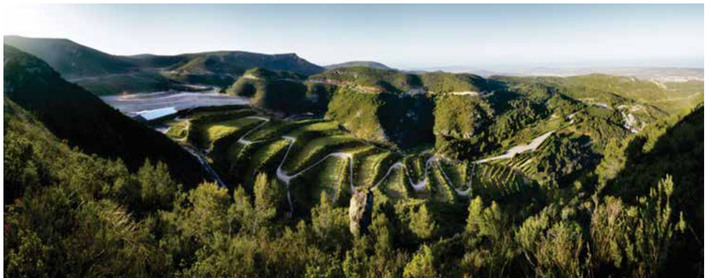
Figure 61- The Vall d'en Joan landfill restoration project
