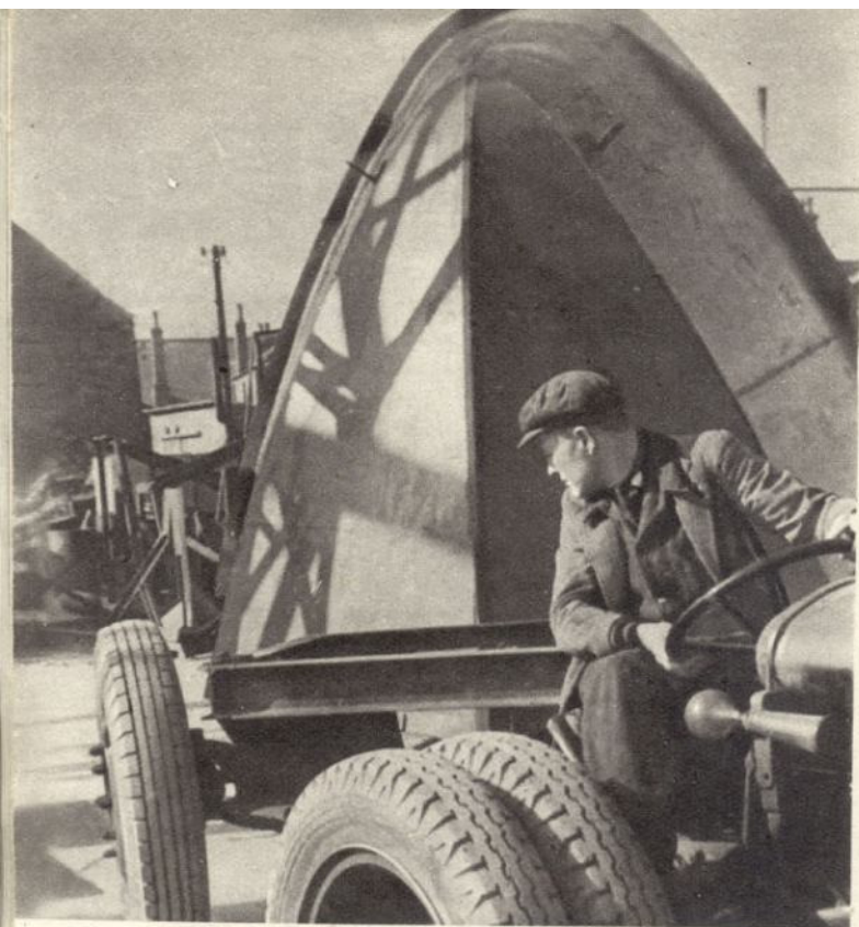
De sleepboot wordt in acht van te voren gefabriceerde stukken per vrachtauto naar de werf vervoerd.
