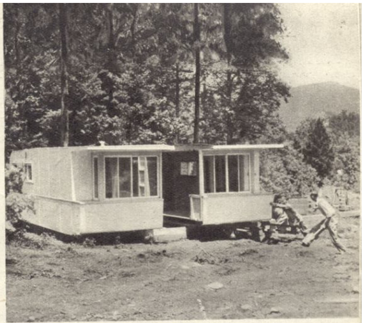
De twee afzonderlijk vervoerde helften worden op hun plaats gerold over de planken heen, die op een eenvoudig fundament van balken zijn aangebracht.
