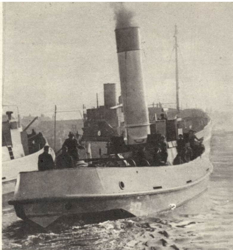
Daarna worden de machines en ketels gemonteerd en vervolgens wordt de bovenbouw afgewerkt.
