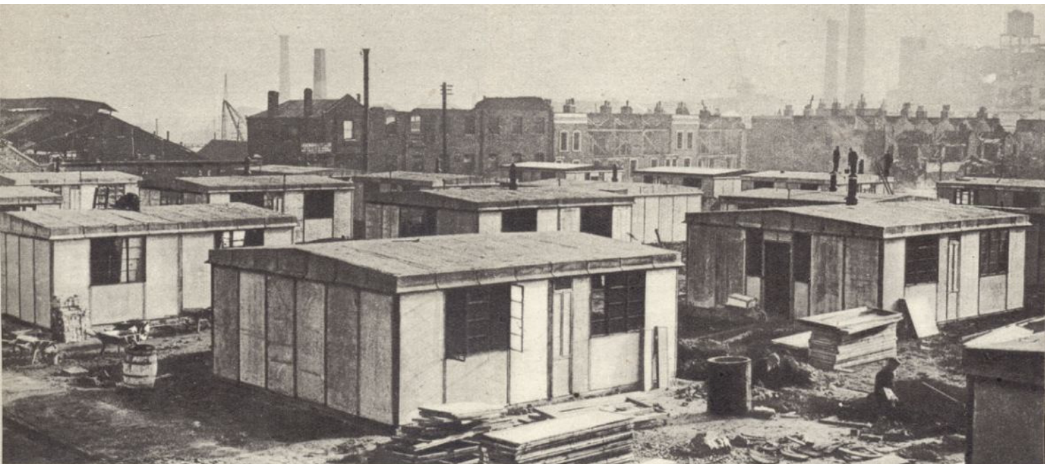
Op de plaats, vrijgekomen door het wegruimen van ruïnes, zijn tientallen noodwoningen gebouwd, die aangesloten worden op het bestaande electriciteitsnet.
