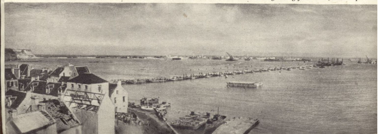
De voltooide haven in Arromanches. De verschillende onderdeelen werden in Engeland gefabriceerd, met sleepboten
