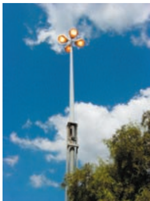
FIG. 1.4.19 Existing site lighting
