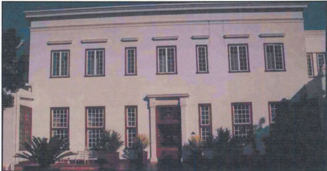
Figuur 32: Die noordelike aansig van die woning.
