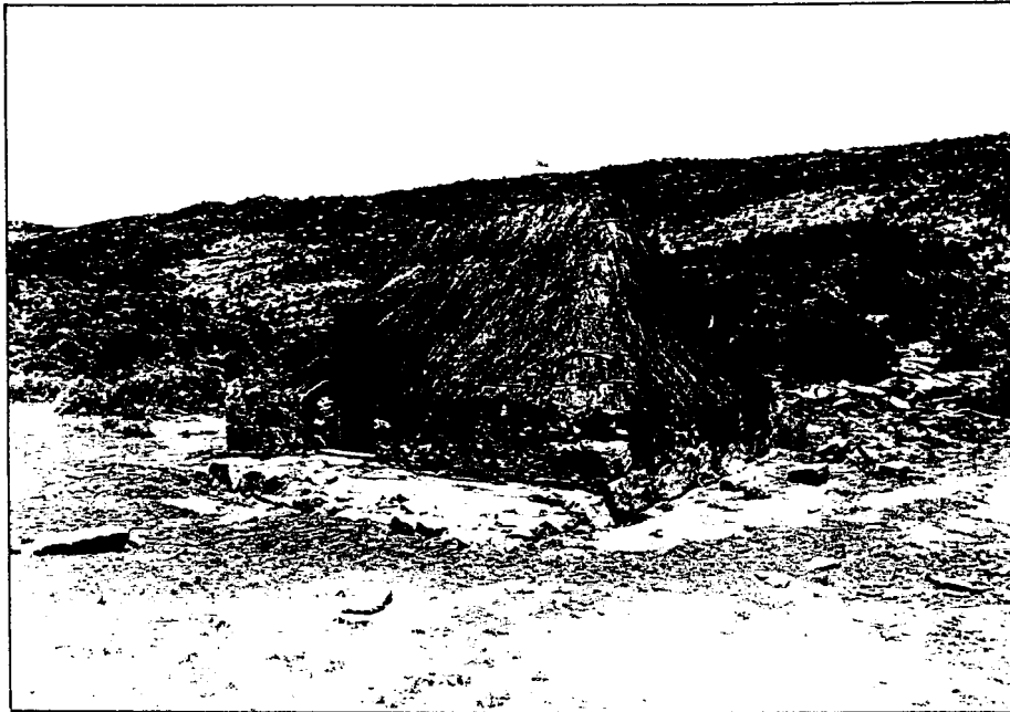
Figuur 108. 'n Ontwikkelde kapstylhuis met ongelaagde ruklipmure en 'n skilddak. Die deur is in een van die lang sye. Waarskynlik Noordwes-Kaap, 1983.
