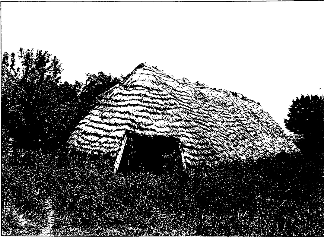
Figuur 94. 'n Kapstylstoor met geronde ente. Dit was waarskynlik 'n tabakdroogstoor op die plase Blauwbank of Vaalbank teen die suidelike hang van die Magaliesberg. (Foto deur Kassel, ca. 1900).
