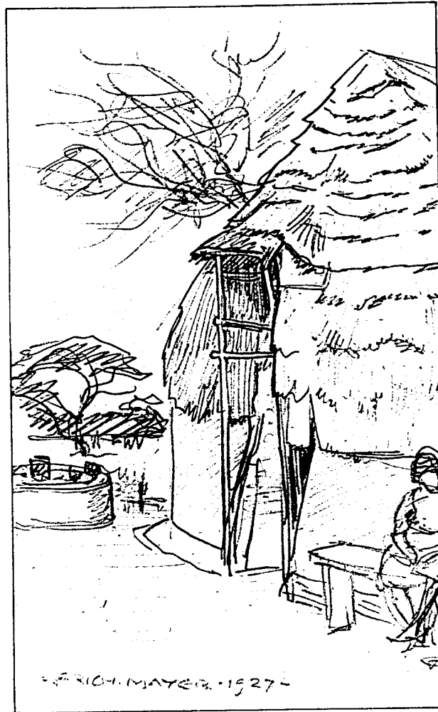
Figuur 74. 'n Bootvormige hartbeeshuis waarvan die onderste gedeelte van die dakmure binne en buite gepleister is. As gevolg van die skuins gewelvlak, is die deur na binne ingelaat, terwyl die pale vir die tuitjie by twee van die gewelvoete ingeplant is. (Erich Mayer, Transvaalse Bosveldwoning, noord van Brits, volgens Voortrekker-tradisie gebou , Tekening, 1927).
