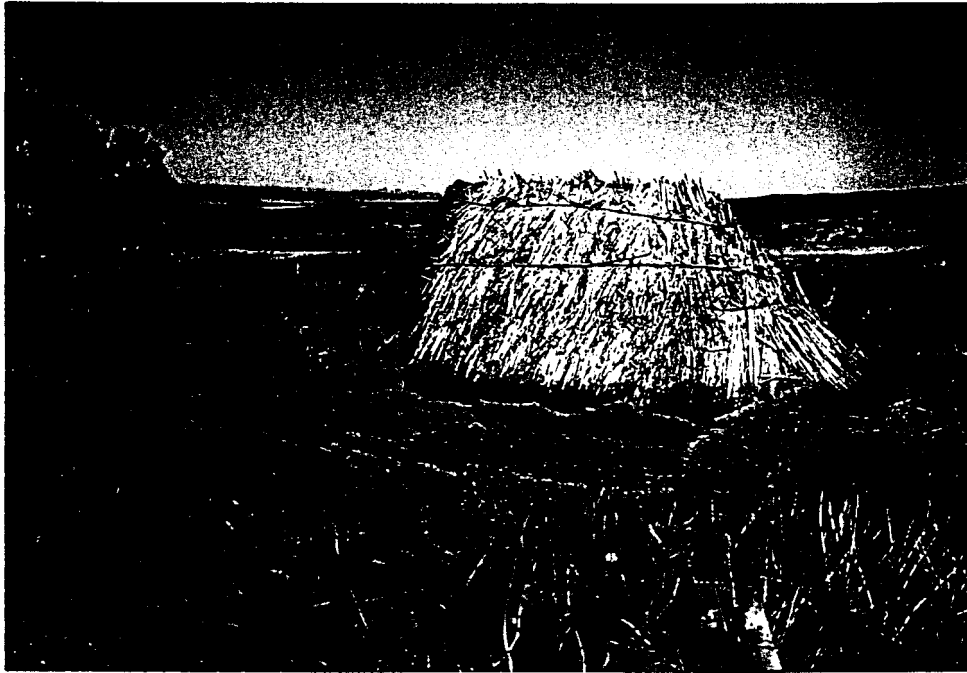
Figuur 100. Die ruïne van 'n saaldakvormige kapstylhuis met lae symure te Goedverwacht, Piketberg, Wes-Kaap, ca. 1969.
