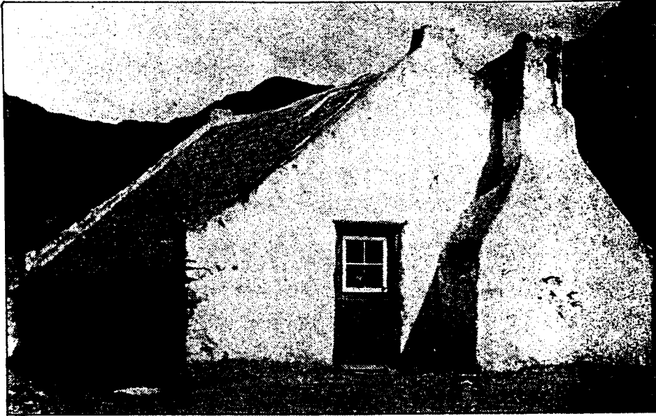
Figuur 115. 'n Ontwikkelde dakhuis met 'n vorkondersteunde-nokpaalkonstruksie, vrystaande gewels en 'n vuurherd. Die gewels en vuurherd is gepleister en afgewit, Krakeelrivier, Langkloof, distrik Uniondale, Suid-Kaap.
