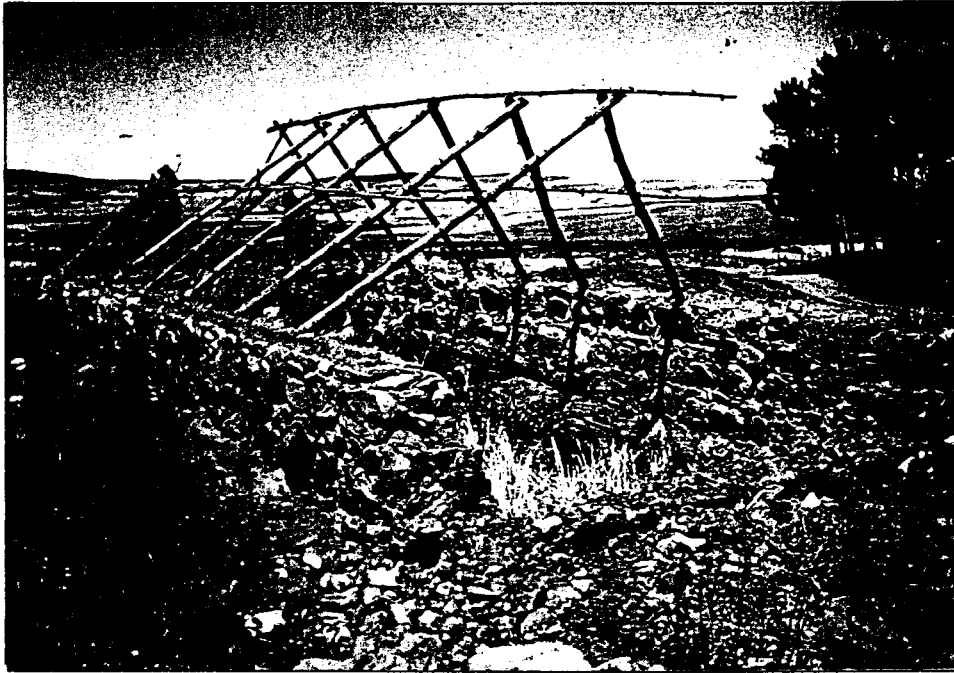
Figuur 101. Die ruïne van 'n saaldakvormige kapstylhuis met lae symure. Die symure bestaan uit ongelaagde ruklip en die voorgewel uit rou stene, Wittewater, Piketberg, Wes-Kaap ca. 1969.
