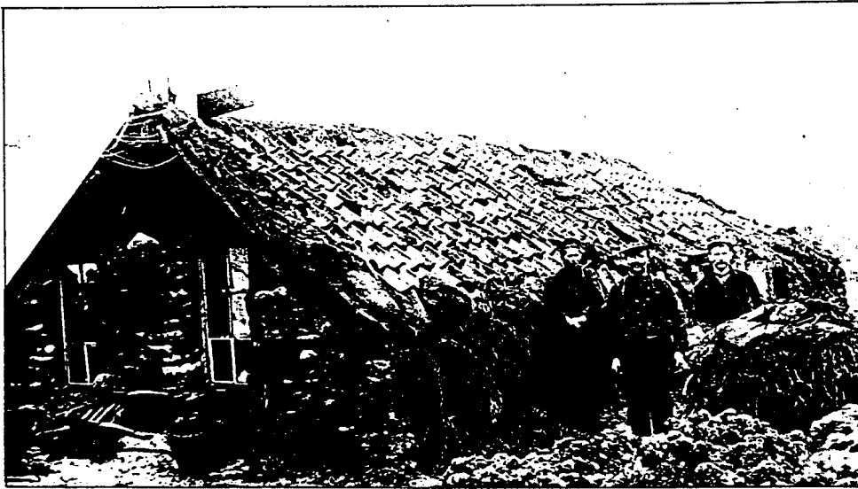
Figuur 55. Die dakpanbedekte plaggenhut (kapstylhuis) van Willem Mulder, Wijk K nr. 149 in Tange, gemeente Onstwedde, Groningen, Nederland, voor 1915.
