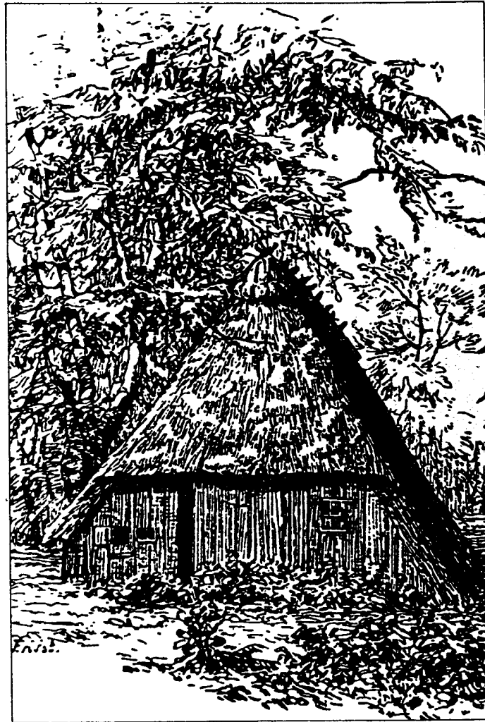
Figuur 47. 'n Sparrenhaus , Sundewitt (Angeln), Duitsland. Die benaming Sparrenhaus het dieselfde betekenis as kapstylhuis, naamlik 'n wigvormige dakhuis waarvan die dakraamwerk uit kapsparre of -style en hanebalke saamgestel is (Ndl. sparrendak ).
