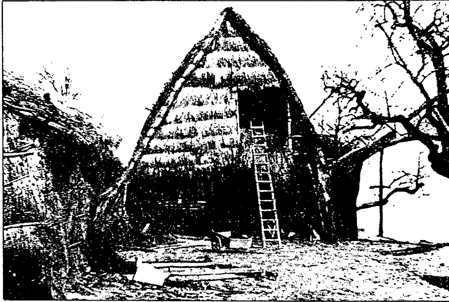
Figuur 33. 'n Bootvormige waghenberg (waenhuis) met 'n hooisolder, Mailen-Courrière, Namen, Wallonië, voor 1950.
