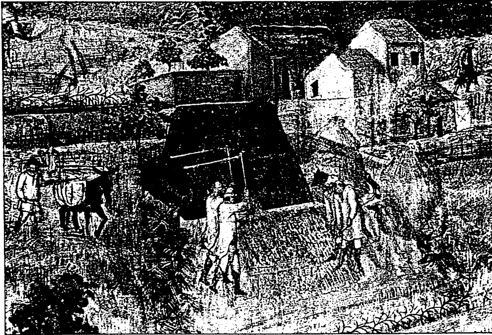
Figuur 40. 'n Wigvormige dakhut met 'n vorkondersteunde-nokpaalkonstruksie op landerye buite 'n Italiaanse stad, vermoedelik Siëna. (Ambrogio Lorenzetti, Die gevolge van 'n goeie regering (detail), skildery, 1337-1340).
