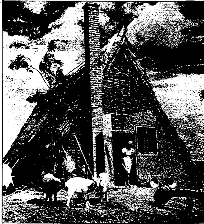
Figuur 70. 'n Hongaarse skaapwagtershuis (kapstylhuis). Die voor- gewel bestaan uit vlegwerk wat met 'n klei- of grondbmengsel gepleister is. Die hoë skoorsteen is 'n aanduiding dat daar binne langs die deur 'n stoof is. (Foto deur Werner Bischof).
