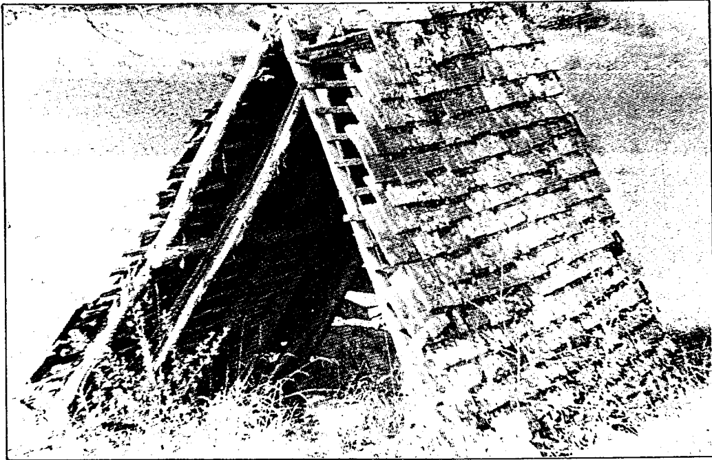
Figuur 64. 'n Skaapherdershut (kapstylhuis) met oop gewels in die Auvergne, Frankryk, waarvan die dakvlakke met spane bedek is.
