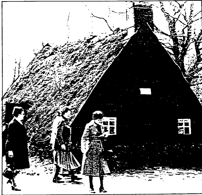
Figuur 56. 'n Plaggenhut (kapstylhuis), waarvan die sluitgewel met 'n plankbeskot bedek is, in die opelugmuseum De Zeven Marken, te Schoonoord, Nederland.
