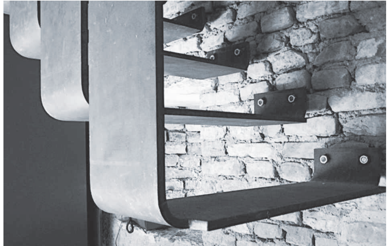
fig. 6.5. Scarpa's steel stair detail at the Museo di Castelvecchio. (centralbranchlibrary.com:2010)
