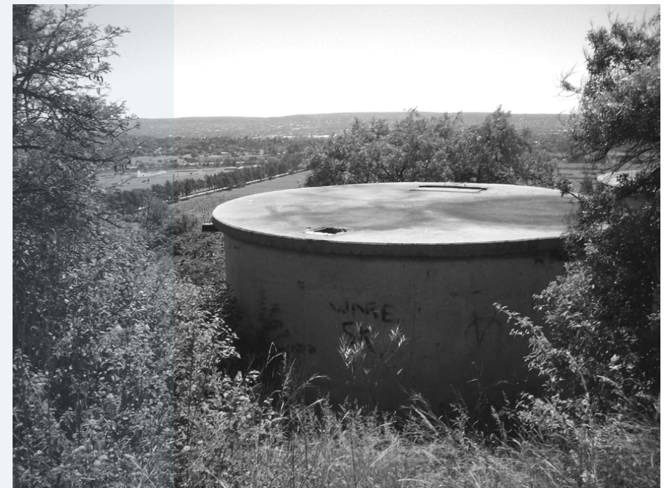
Fig.117: Die reservoir op Strubenkop (foto: outeur).
