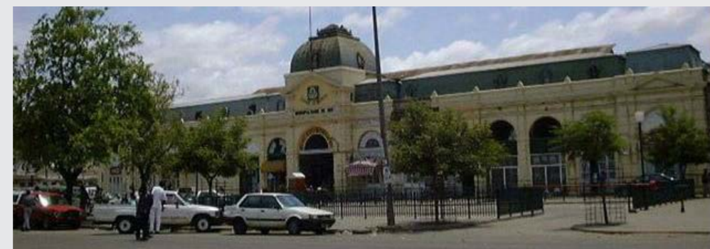
Illus. 85: Ave 25 de Setembro Street facade, Maputo Central Market, Maputo
