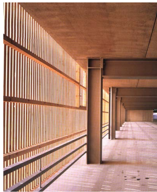
FIG 4.37 Parkhaus am Bollwerksturm, Heilbronn (Henley 2007:180)
