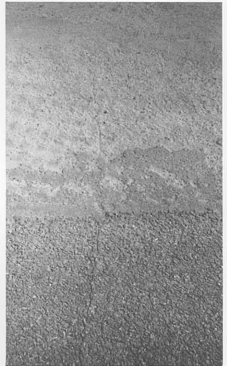
(b) Stabilisation crack.
