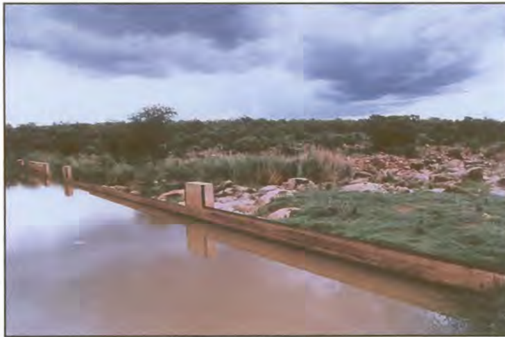
Figuur 9.2 'n Keerwal in die Olifantsrivier vir die opdam van water vir besproeiingsdoeleindes in die Marble-Hall-omgewing
