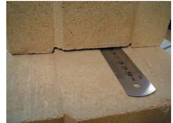
Fig. 5.34 Spleet tussen drooggepakte blokke wat invoeg van staalplaat moontlik maak
