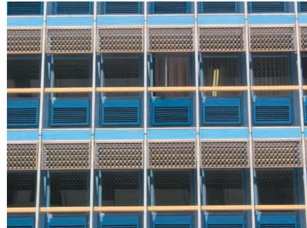
Fig. 2.8 Sonbeheerelemente op fasades van moderne kantoorgeboue. Horisontaliteit van fasades versterk oos-wes as van kloof deur geboue.
