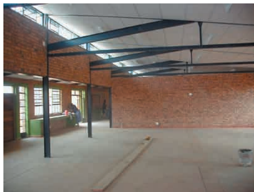
Fig. 3.8 Binnekant van klaskamer met bloot-gestelde staalkappe
