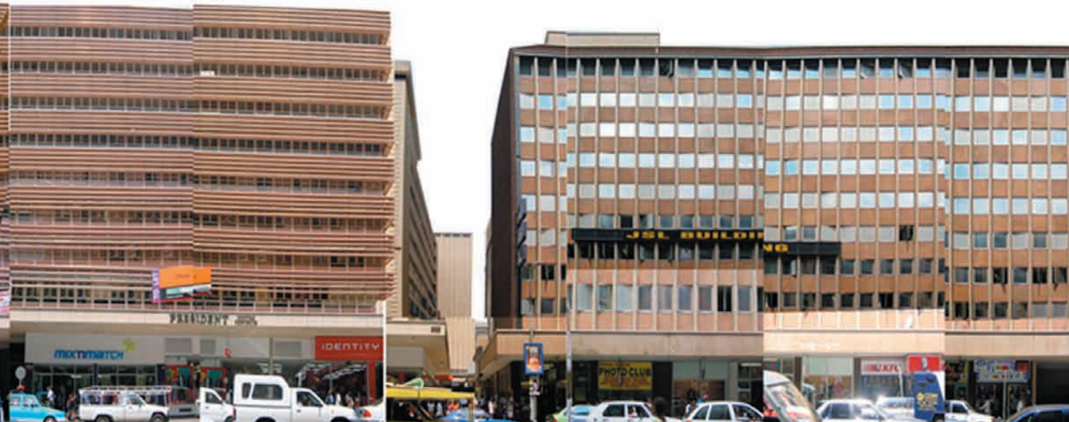
Fig. 5.61 Die skool as deel van Pretoriusstraat se aaneenlopende moderne straatfasade
