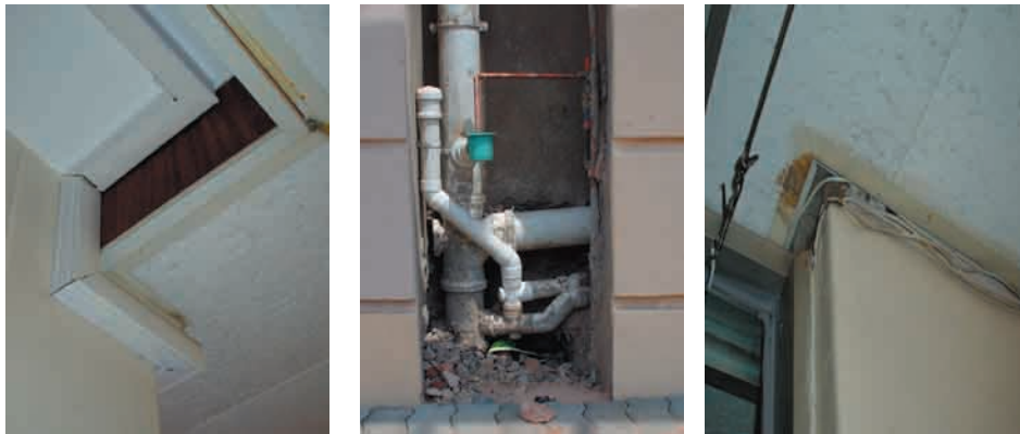
Fig. 5.36 Gebrekkige beplanning van diensteverspreiding is dikwels onooglik
