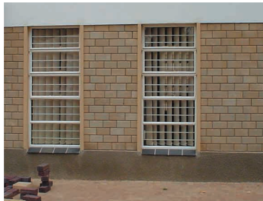
Drooggepakte sluitblokmuur
