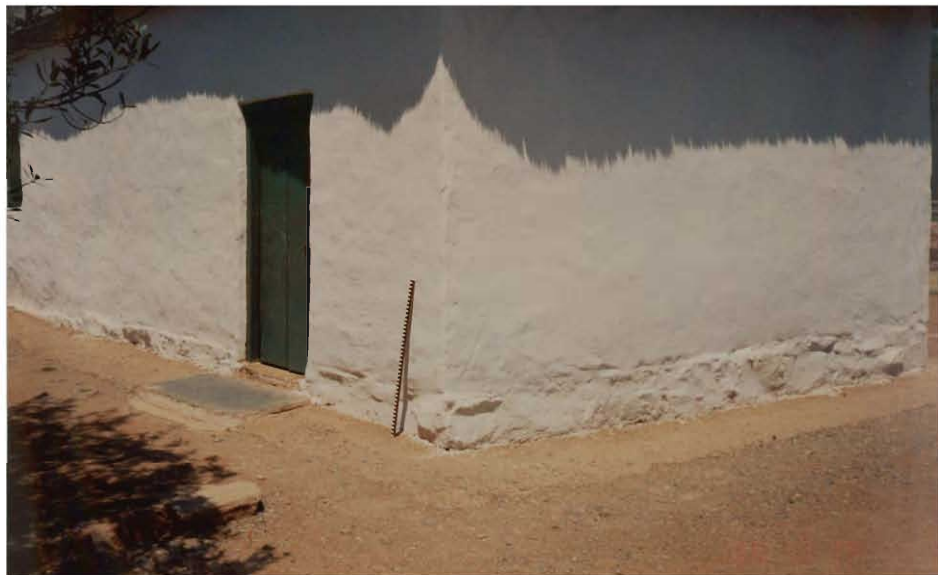
Figuur 5.15 Die klipfondament is duidelik sigbaar by die Pioniershuis in Silverton.
