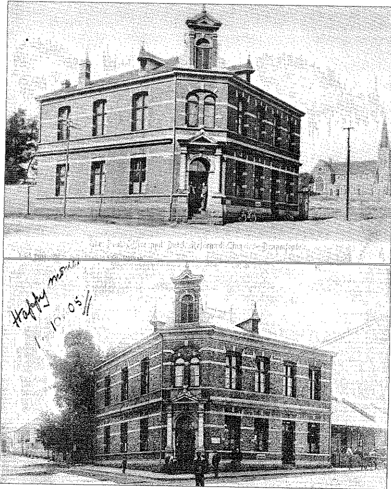
Fig 3.44: Braamfontein poskantoor (bo) en Jeppestown poskantoor (onder) – die 'Publieke Werken' se enigste gestandaardiseerde poskantore, wat steeds elkeen uitkenbaar bly aan afsonderlike detailafwerking. Poskantore, as nutsgeboue, se indaane word op die hoeke oeblaas (Norwich 1986: 94.139).
