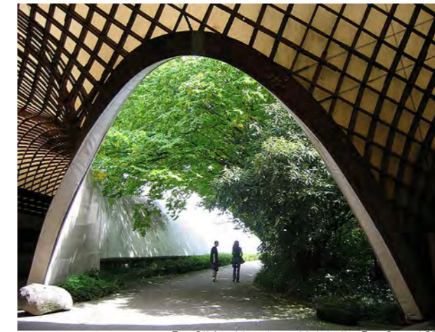
Fig. 246 Mannheim Multihalle, Frei Otto, 1975
