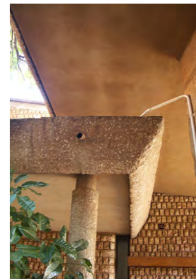
Fig. 268 Roof edge NG Universiteitsoord
