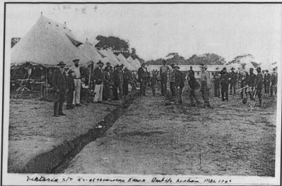
Figuur 12: Umbilo-kamp met sy ovaalvormige tente. Die kantseile van die tente is opgerol, soos die kampregulasies vereis het. In die voorgrond is 'n afvoersloot vir reënwater.
