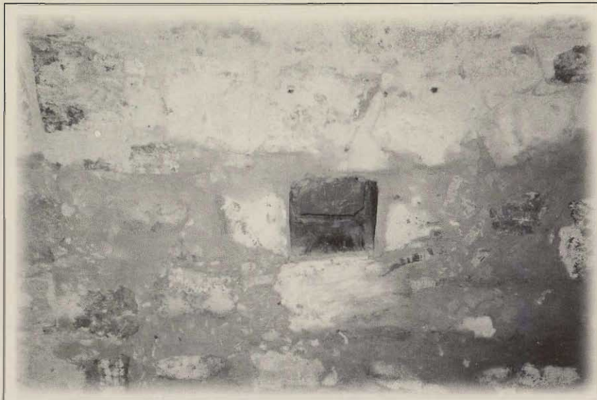
Figuur 8. Restourasiewerk aan die gang by Fort Klapperkop.
