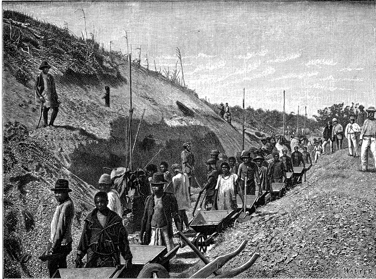
Aanleg van een spoorweg in Transvaal.
