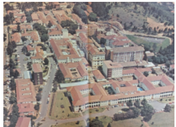
Figure 86 H.F. Verwoerd Hospitaal (Snyman & Serfontein, 1977)
