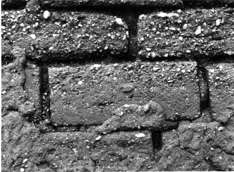
31. Die gebruik van roustene in 'n muur
