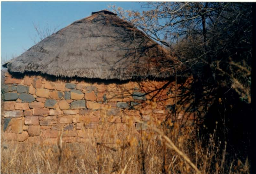
12 Klipverband op Oostelike fasade
