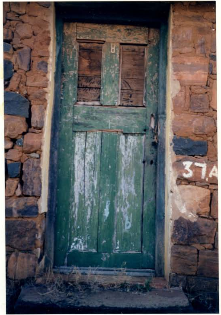
5 Detail van deur B, en drumpel van sement
