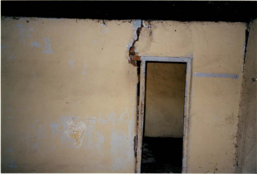
Binne-muur met deuropening D
