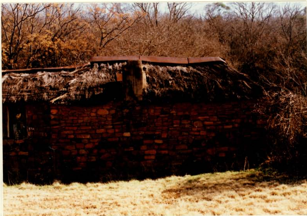
10: Suid aansig - klipwerk
