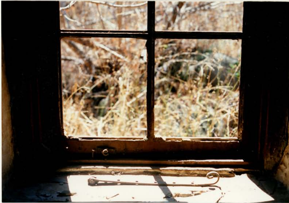
7 Rame en onderafdelings getuig van goeie vakmanskap. Rame is in muur bevestigig met staalspykers.
