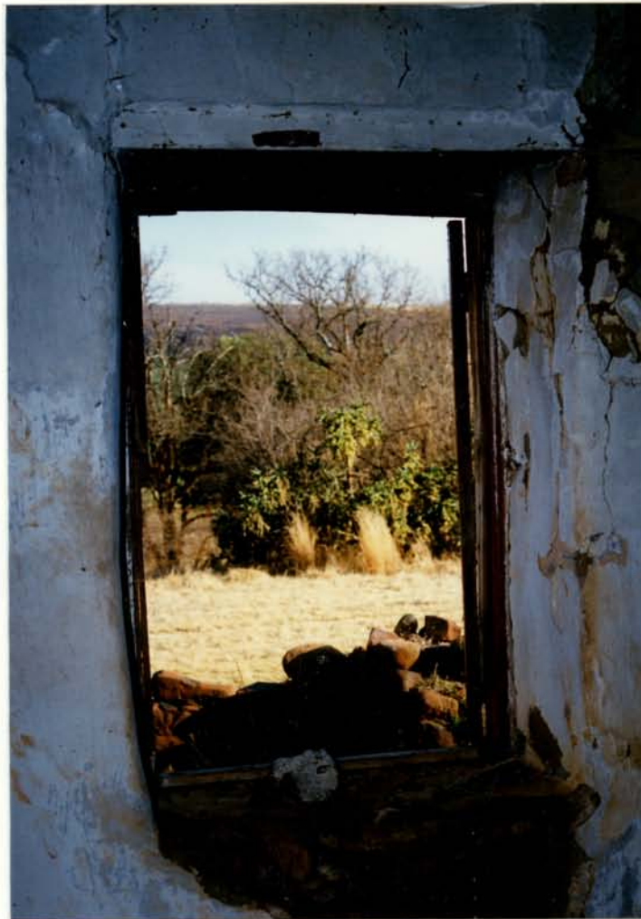
Binnemuur- en vensteropeningafwerking van huis.
