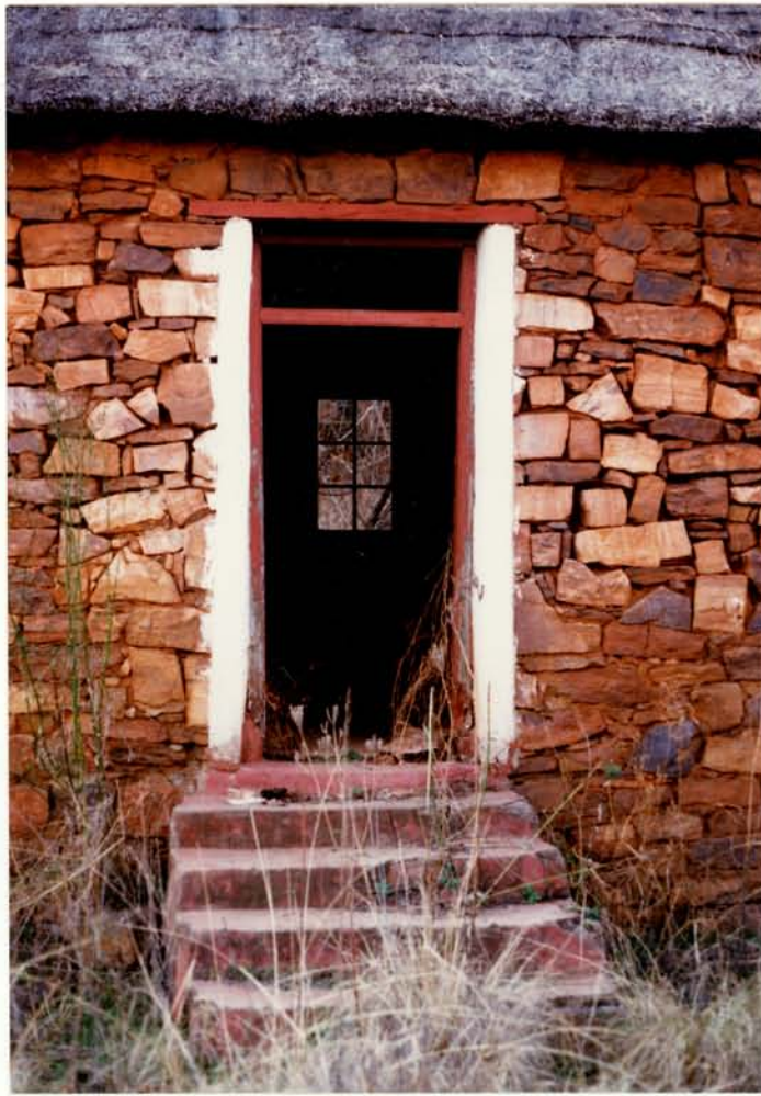
Trappe is gebou van klip, met 'n sementlaag daaroor. 15
