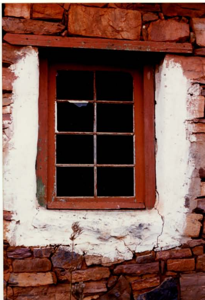
6 Openinge is omraam met uitgeverfde sementpleister en oorspan met houtlatei, in die muur ingebou.
