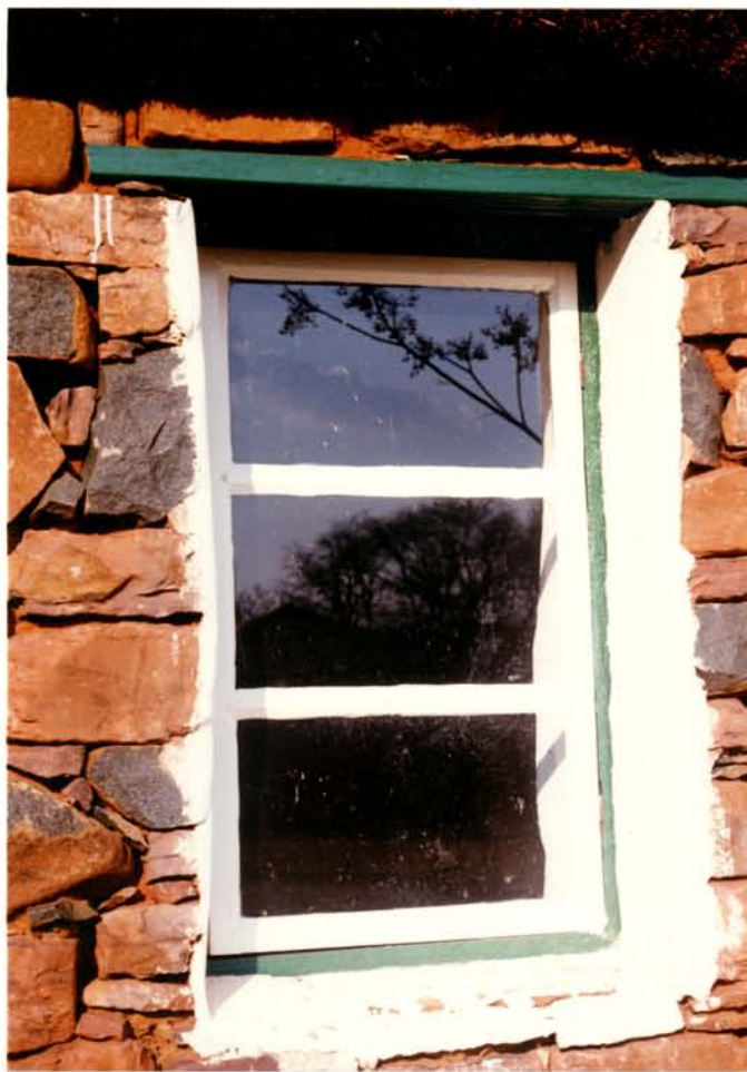
10 Vensterdetail (westelike muur)
