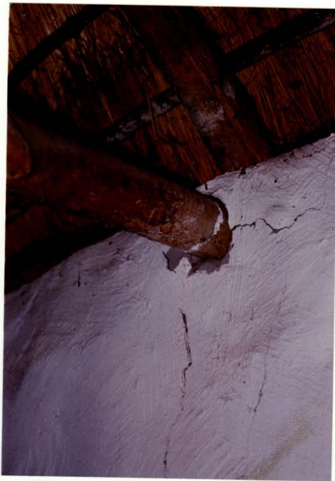
15. Dak en kap
