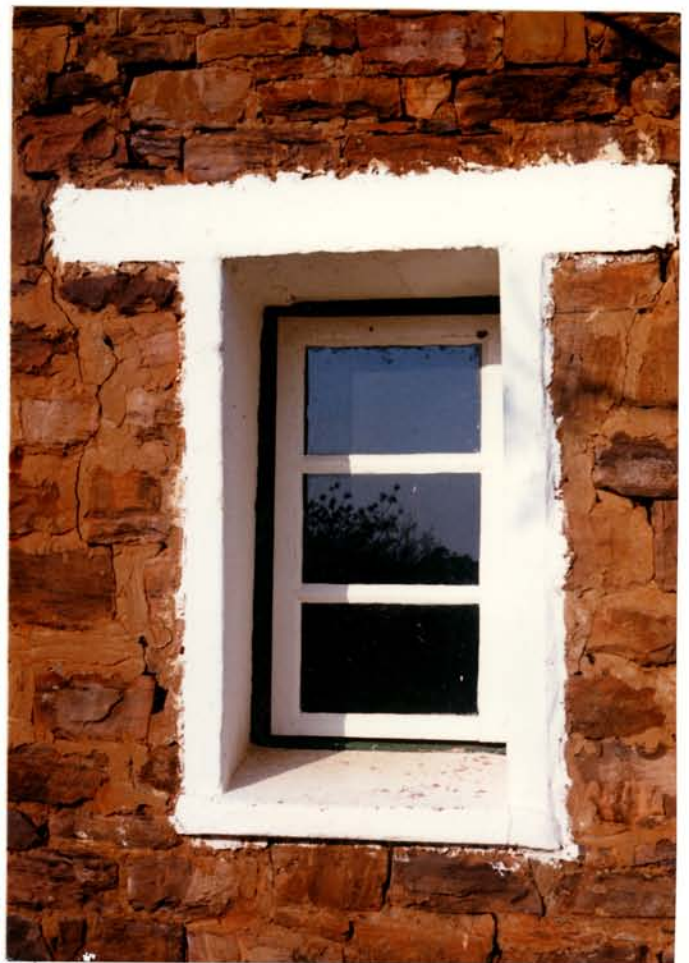
11 Vensterdetail (westelike muur)
