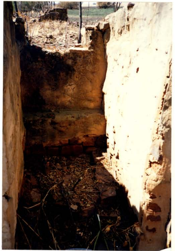
Toilette, 11.22, in die suidoostehoek van die woninggroep
