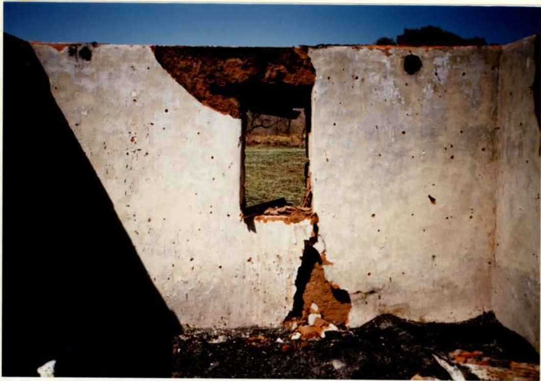
3. Posisie van dakbalke, en binnepleister.
