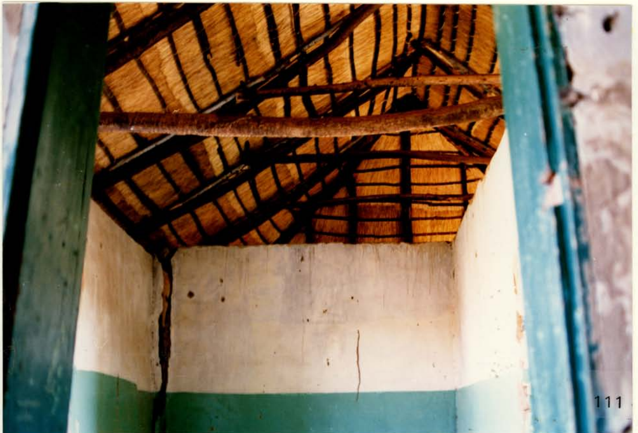
1. Dakruimte van woonhuis
