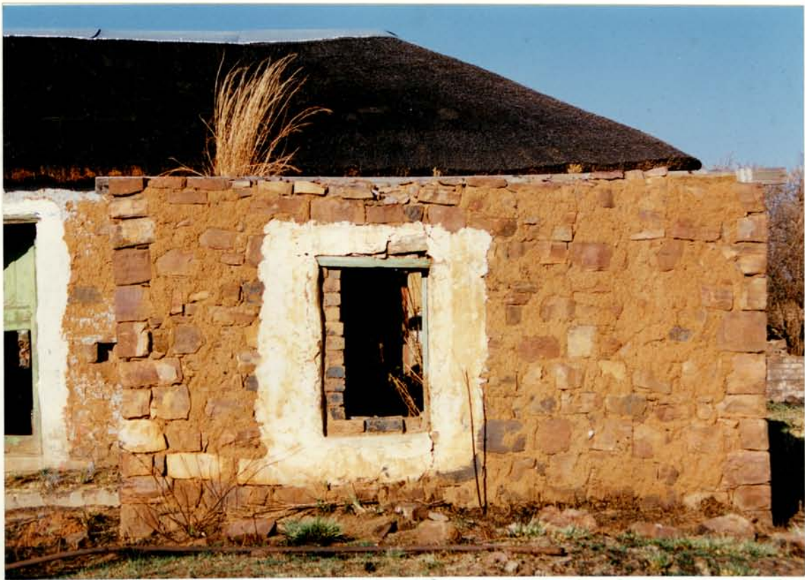
26. Baksteenwerk in vensteropening bygevoeg Rede onduidelik
