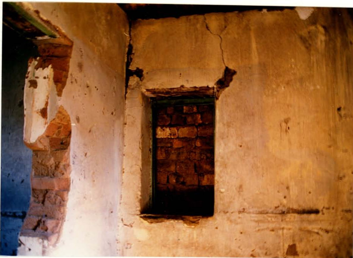
28. Toegebooue venster in suidemuur van binne
