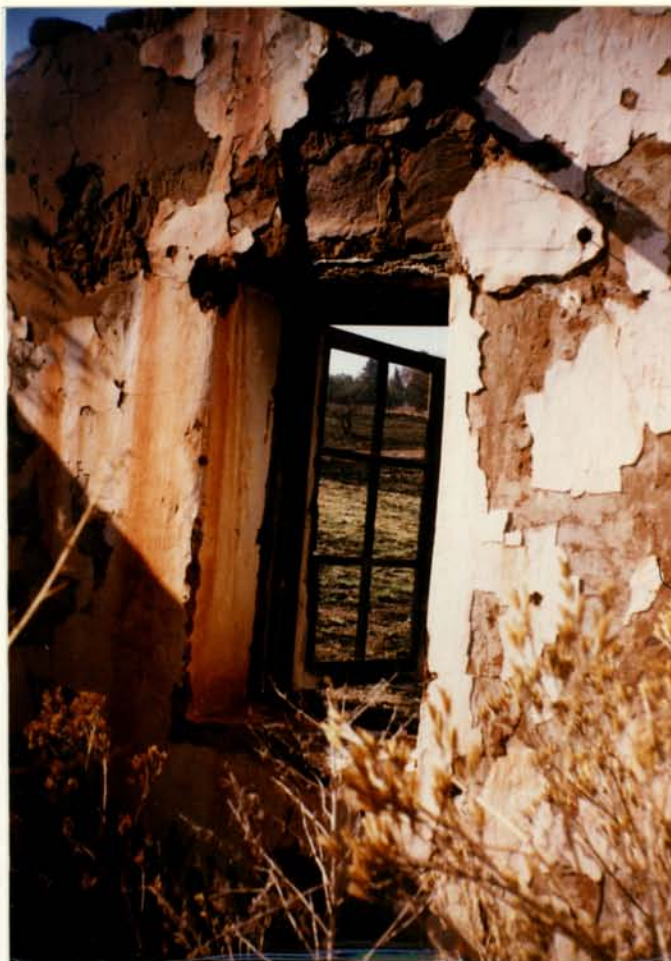
4. Gepleisterde klipwerk en venster suid
