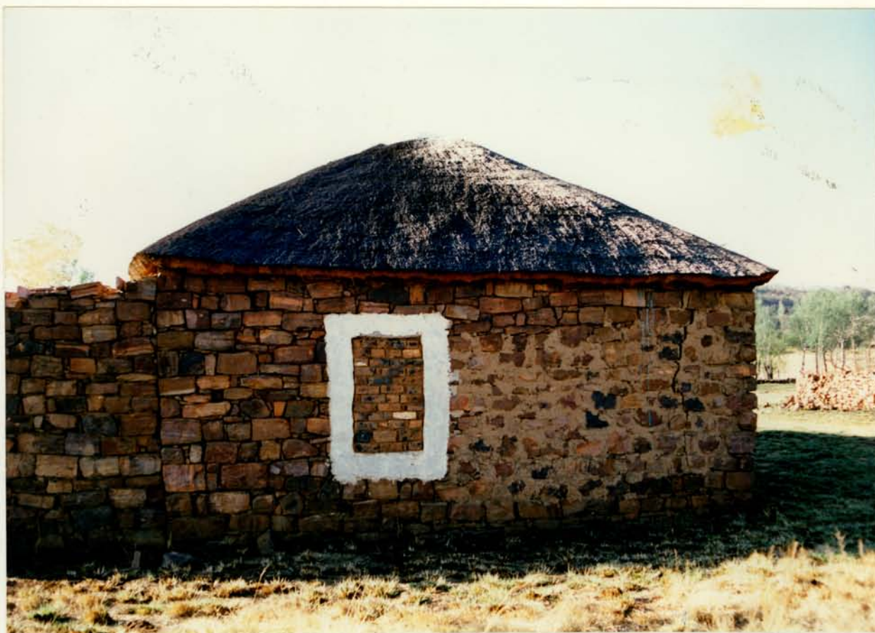
30. Suideaansig met toegeboude venster en lyn van aanbouing
