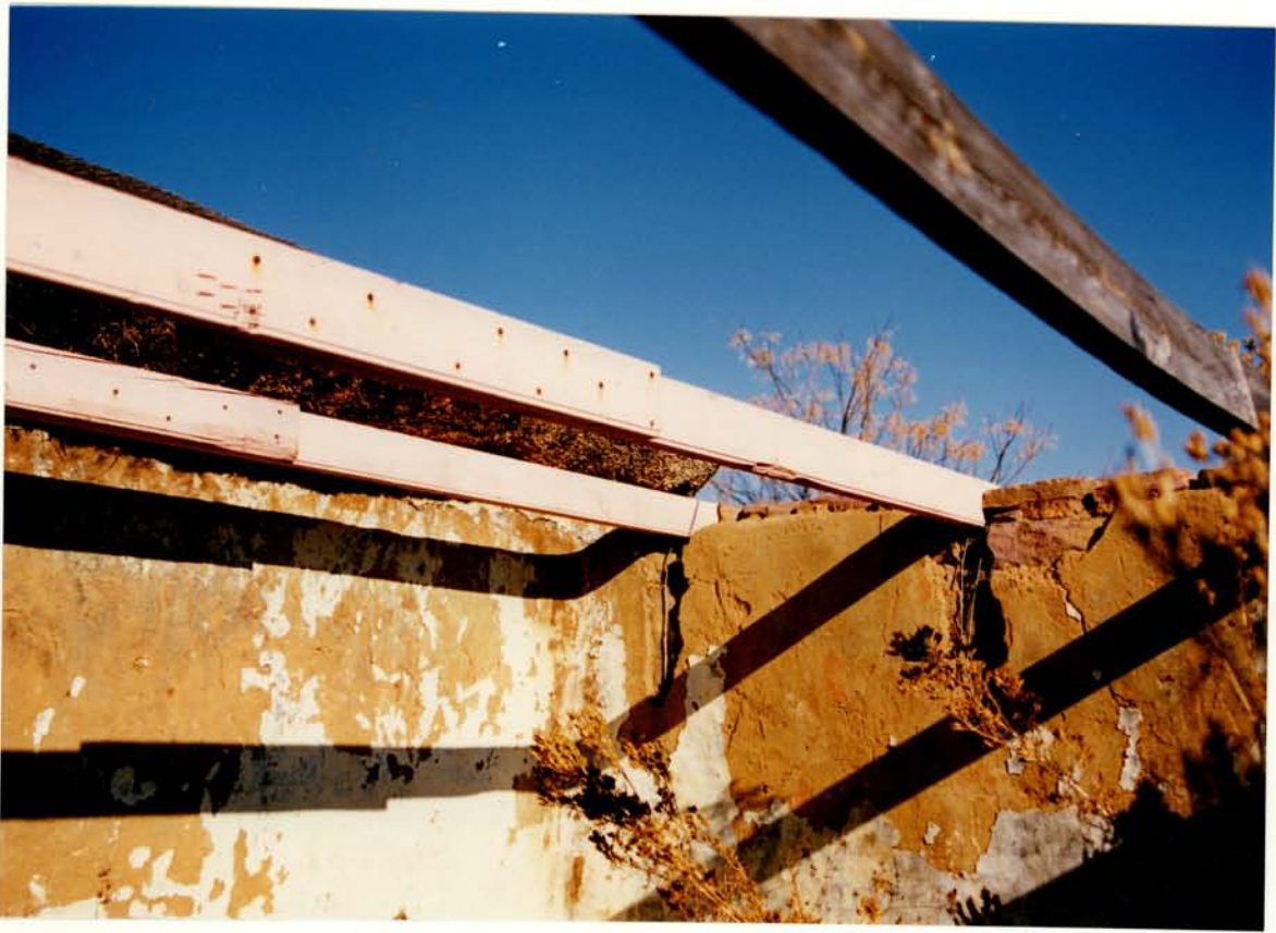
24 & 25. Dakbalke, muurankers en pleisterwerk in aanbouing
