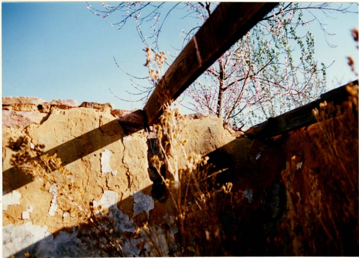
24 & 25. Dakbalke, muurankers en pleisterwerk in aanbouing
