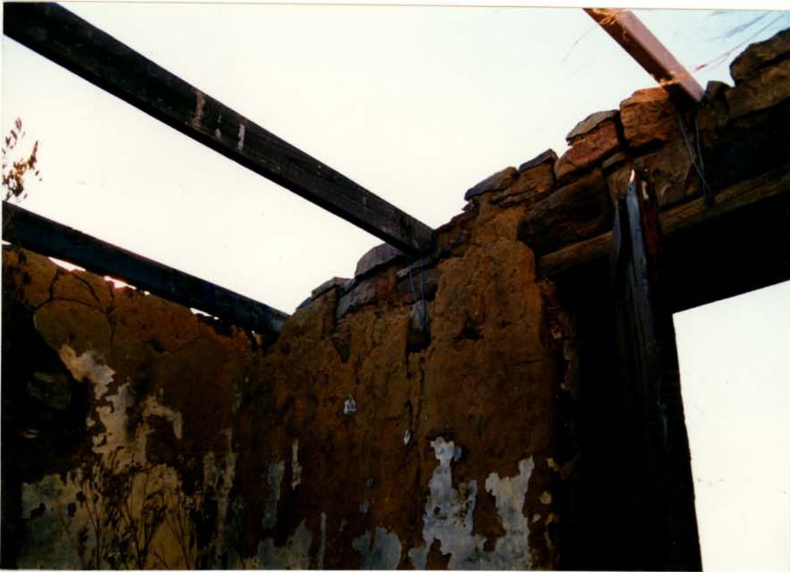
6. Dakbalke vir platdak oor aanbouing
