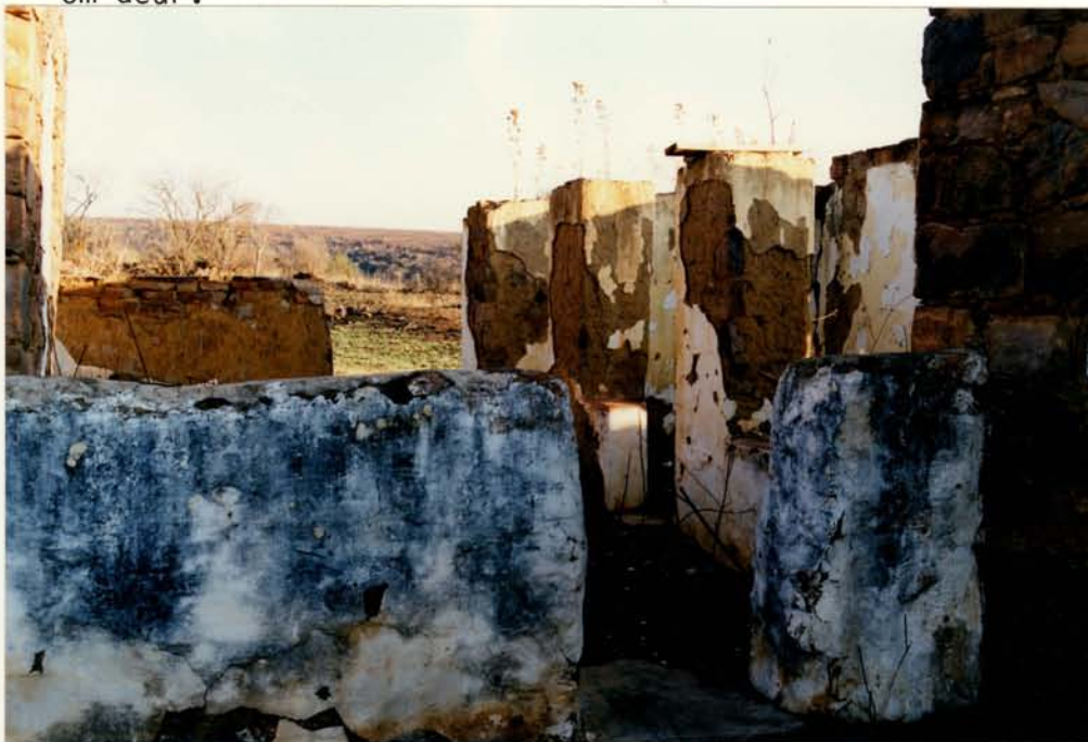
Foto 10. Binnehof met stoepkolomme. Witgeverfde sementpleister op muurtjies en modderpleister op stoepkolomme.
