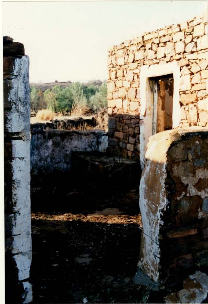
Foto 9. Onbedekte binnehof tussen Kamer 1 en stoep, met sitbankie voor kamer 1. Merk witgeverfde sementpleister op muurtjies, sitbankies en rondom deur.
