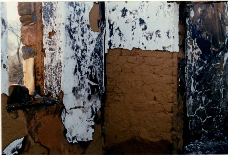
Foto 8. Witgeverfde modderpleister aan binnemure val orals af. Merk ook ongebakte kleisteen binnemure.
