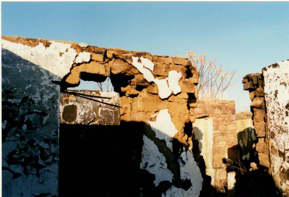
Foto 12. Modderpleister aan binnemure val orals af. Lateie onstabiel of ingestort.
