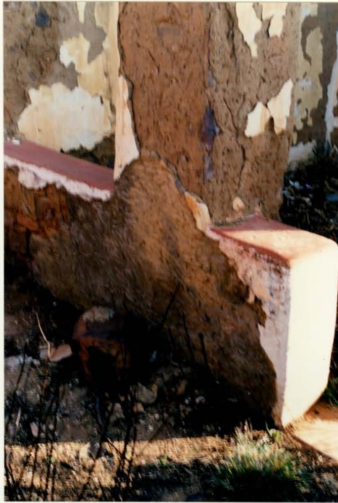
Foto 11. Rooigepolitoerde stoepmuurtjies. Modderpleister val orals af.
