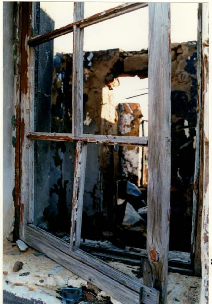
Foto 15,16,17. Min vensterbeslag is oor. Vensterraam en pleister verwoes in brand.
