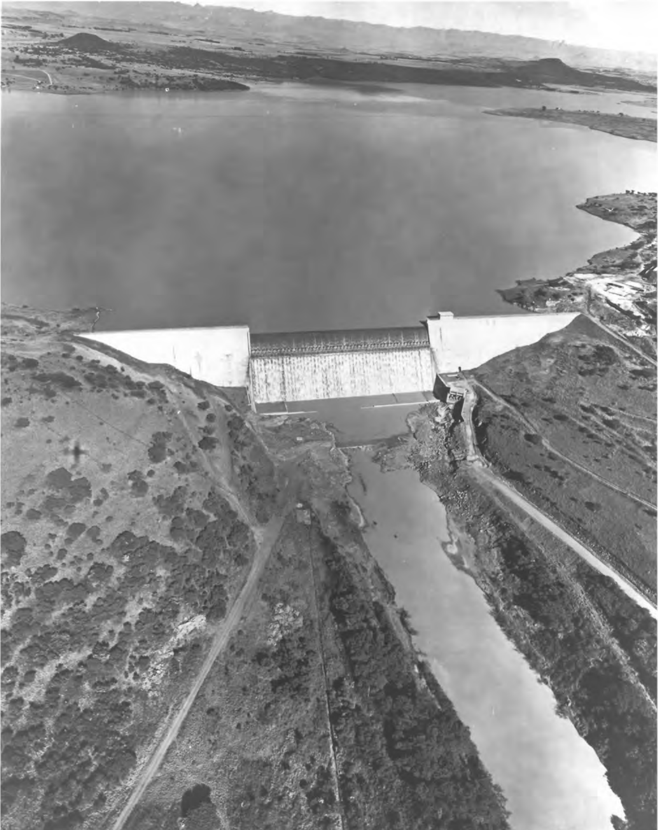
FOTO 3.6.2 SPIOENKOPDAM (Foto: Departement van Waterwese)
