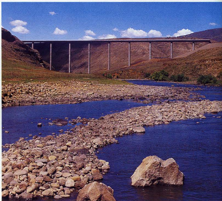
Hierdie brug wat deur Suid-Afrikaanse maatskappye ontwerp en gebou is, is 85 m bokant die bedding van die Malibamatsorivier en sal nie oorstrom word wanneer die water in 1996 in die Katsedam styg nie. Die verbindingspad moet nog gebou word
