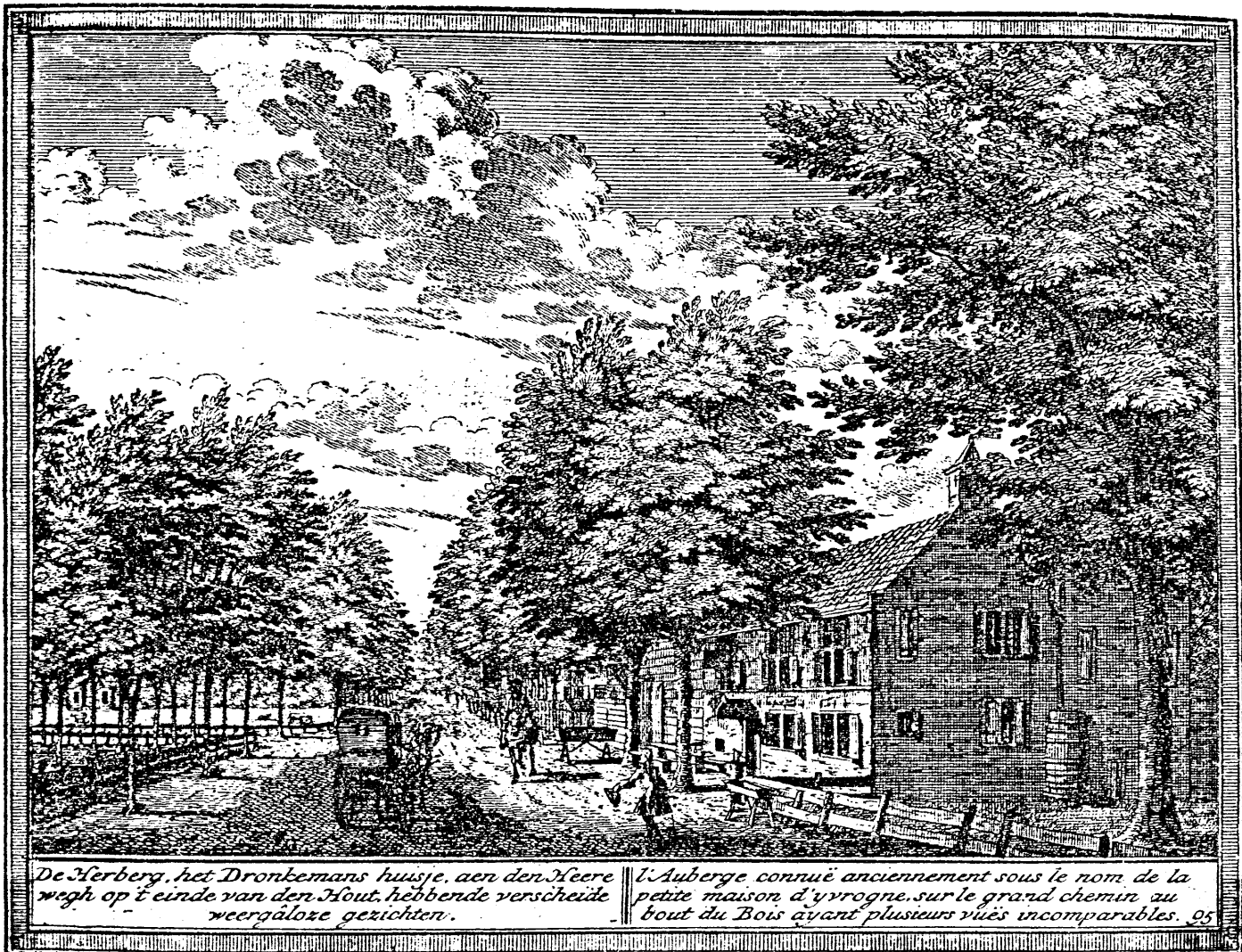
(15.5) An Old Dutch Tavern. Note the series of bolkozijnen on the ground floor with kruiskozijnen above (Hendrik de Leth, Het Zegenpralant Kennemerlant , 1732).
