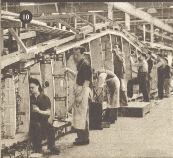
9 Het breekbare foriceerhout is nu een sterke vleugel geworden.
