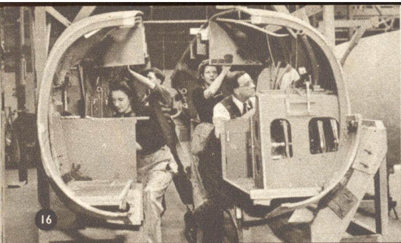
16 De romp wordt van binnen ingericht. 17 Alvorens de vleugel aan te brengen wordt de romp geïnspecteerd.
