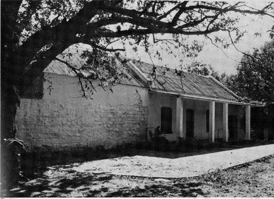
Die historiese opstal op die plaas Kaalfontein voordat daar 'n aanvang met die restaurasiewerk geneem is.
