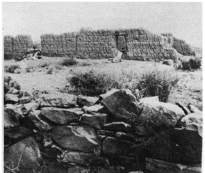
Die venster in die oostelike muur van die kleimurasie op Klipplaatsdrift Foto: O.A. Henning
