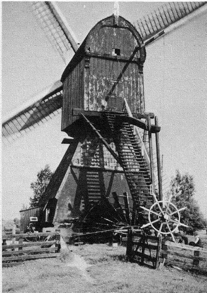
Wipmeul met oop waterskeprat en 'n trap of leer wat deel van die stertwerk vorm.
