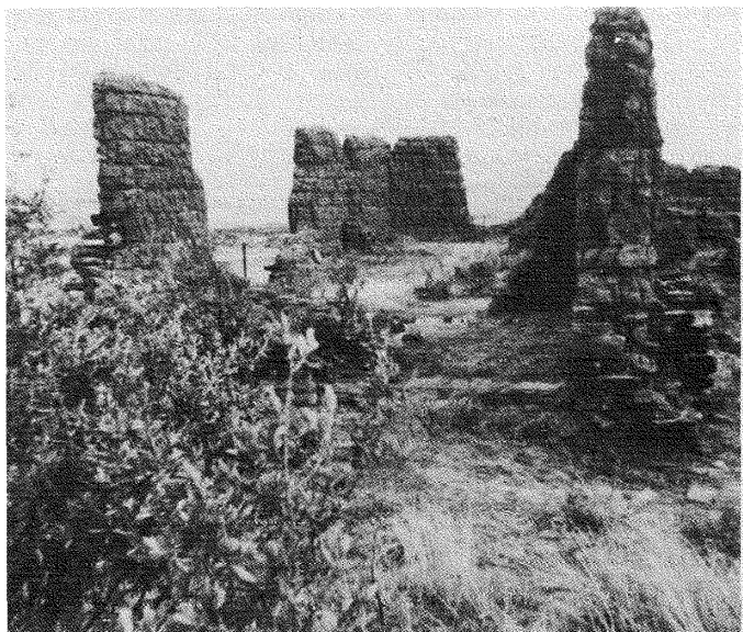
Die fundamente van die woning op Klipplaatsdrift. Dit bestaan uit plat klippe, opmekaar gepak waarvan die sye gedresseer is sodat daar geen uitstekende onooglike punte is nie.
