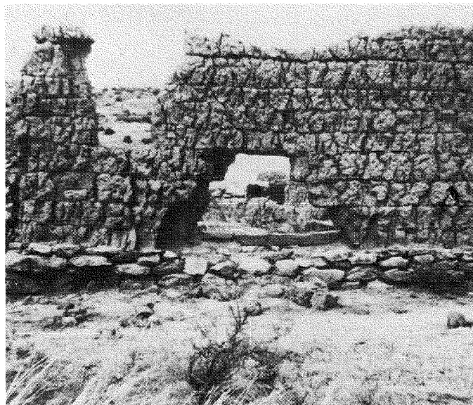
Leesuspruit, vroeër bekend as Waaipoort. Dié foto van die hoofmurasie, geneem vanaf die hoofingang, toon die kombuis te oordeel aan die gat in die suidelike muur wat daarop dui dat daar 'n vuurherd of 'n bakoond was.
