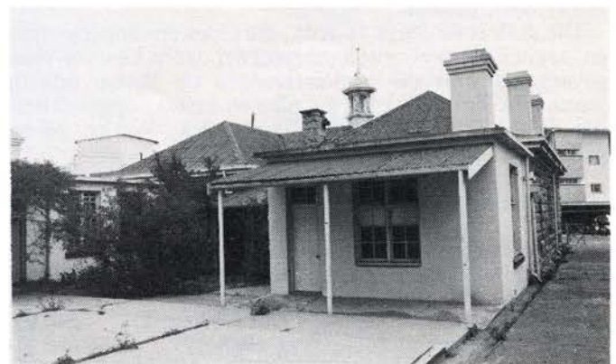
Latere aanbousels aan die agterkant van die Ou Landdroeskantoorgebou wat gesloop behoort te word (Foto: Raad vir Nasionale Gedenkwaardighede).
