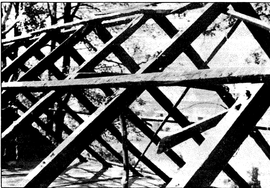
Die waenhuis, perdestal en tuiekamer van die President Pretorius-museum tydens restourasie. Die outentieke dakkapkonstruksie is met sorg so ver moontlik slegs herstel. Van die materiaal wat vervang moes word, word in 'n "restourasie-uitstalling" in die tuiekamer vertoon.
