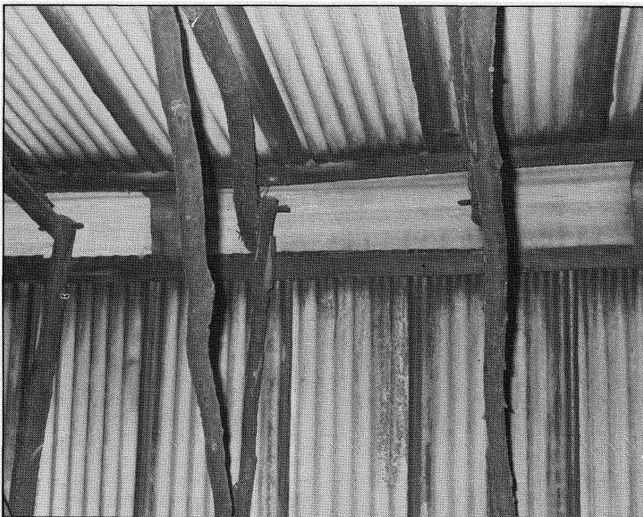
Dakkonstruksie van skuur met houttappe.
