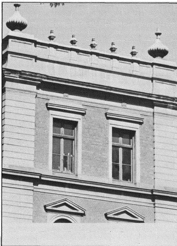
Die vensters van die bygevoegde tweede verdieping met die baldakynagtige pedimente.
