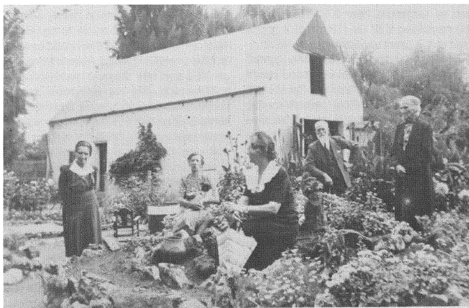
Die gesloopte buitegebou.
