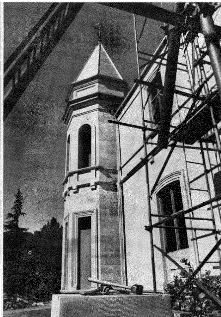
Uit die ruwe sandstene op die voorgrond word die mure weer tot vorige glorie herstel – soos die Suidtoring in die agtergrond. Op die twee rotsblokke lê 'n hamer wat gebruik word om die stene te bewerk Foto: Jan Wessels
