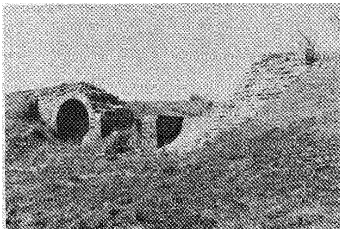
Vervalle gemesselde drieboogbrug, oos van die halte Panpoort (by Pretoria). Links en regs is die ou spoordyk sigbaar.
