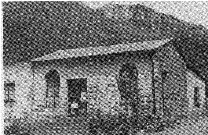
Ploegbaaswoning ("ganger's cottage") naby die NZASM-tunnel. Langs alle NZASM-spoorlyne het tientalle sulke huisies gestaan. Die boogvormige beëindiging van die vensteropeninge is later ingebreek. (Foto: R.C. de Jong)
