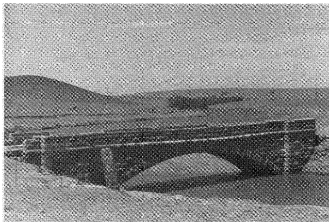
Wilgerivierbrug no. 2 tussen Harrismith en Bethlehem.
