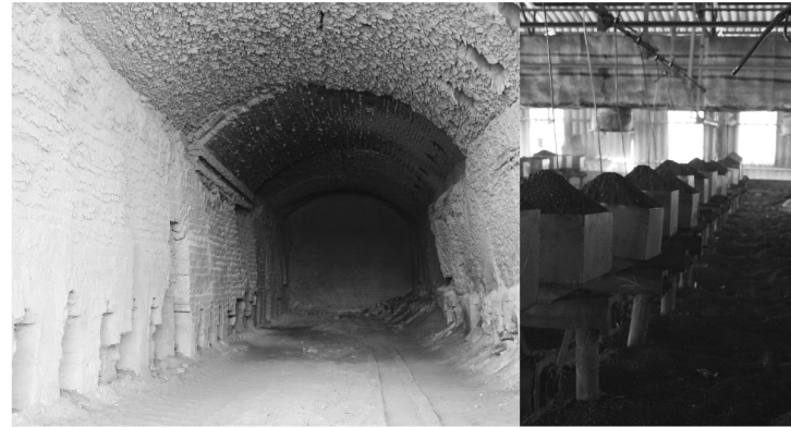
g) drying kilns
