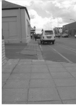
Fig.9 Uneven pavement
